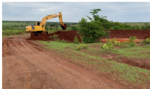
Implantação de bacia de contenção
