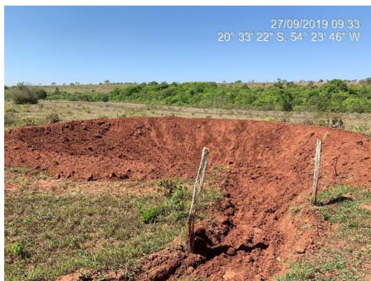
Implantação de bacia de contenção
