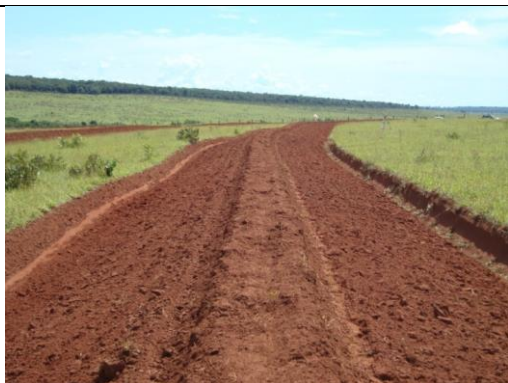
Construção de terraços
