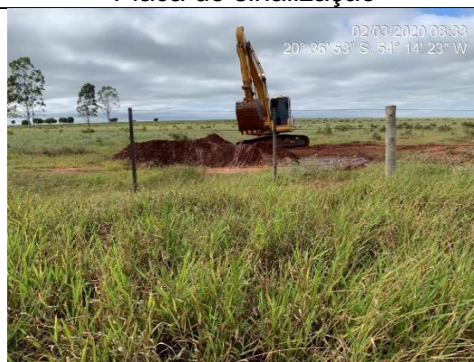
Ampliação de caixa de retenção
